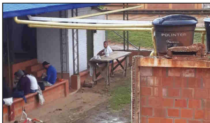
De la canaleta al tanque, usada en Teatrino para los baños.
