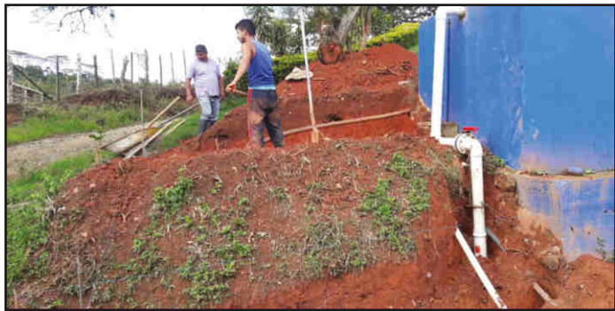
Instalación de nuevas tuberías para la prestación de un excelente servicio.
